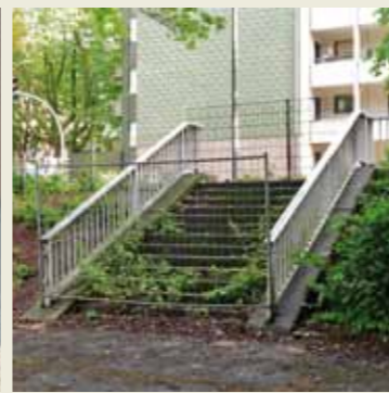
Treppe wird beseitigt
